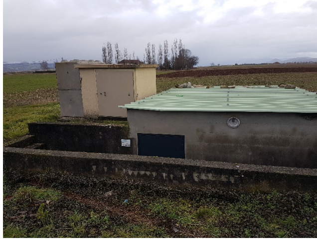
Station de pompage en Bièvre-Liers-Valoire
